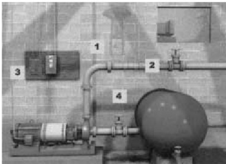
Figuur 50: zelfregelende pompsysteem
